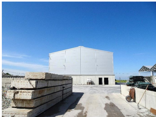
Épül az üzemcsarnok
